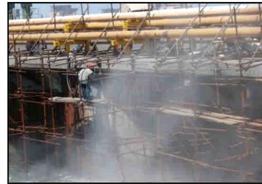
Para prolongar la vida útil de las estructuras metálicas existentes, se inició la rehabilitación de las tablestacas y pilotes metálicos de los muelles "A" y "B" del Puerto de Acajutla, con un 56% de avance y un monto total del proyecto de US\$1,483,033.88.
