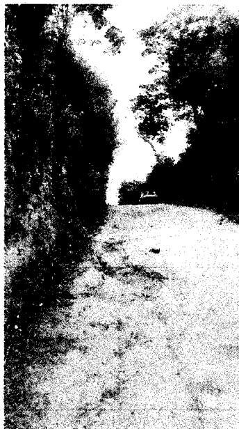
Foto Izquierda: inicio del tramo # 2; La superficie de rodamiento es una conformación del terreno natural que se ve dañada con ondulaciones y erosión del suelo causadas por las lluvias. Foto derecha: parte media del tramo # 2 se observan daños en la superficie del camino.
