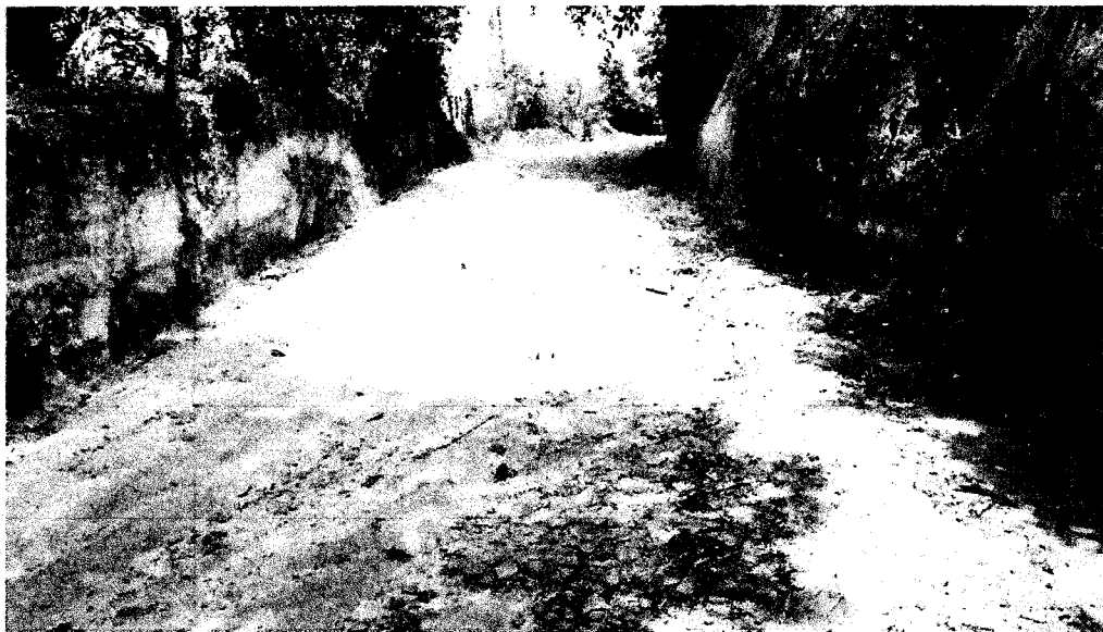
Fotografía del tramo # 1, este tramo termina en una pendiente hacia arriba, el cual es difícil subir en inviernos por los daños en la superficie de rodadura.
