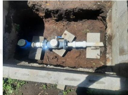
Se recomienda realizar pruebas de arranque, limpieza del tablero, cambio de válvula chek, limpieza del área y tapar el pozo artesanal.
