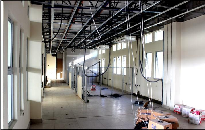
La empresa constructora trabaja en el área administrativa de la Terminal de Integración en la instalación de oficinas y cableado en cielo falso.
