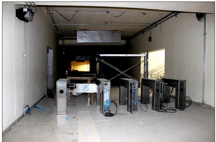
Instalación de molinetes electrónicos en el túnel peatonal por donde ingresarán las personas usuarias a los autobuses.
