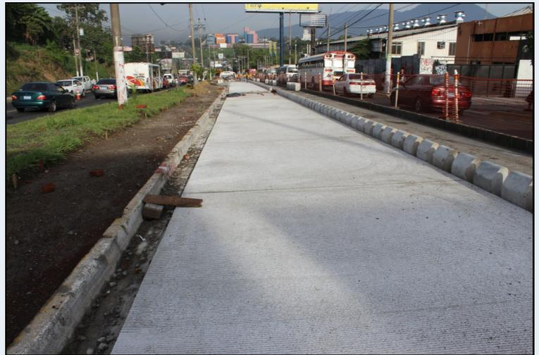
Pista de concreto hidráulico que va desde la Plaza Soyapango hasta el puente Eureka, con un espesor de 32 cm. A la derecha se aprecian los separadores que facilitarán la exclusividad que tendrá el carril por donde circularán los buses articulados del SITRAMSS
