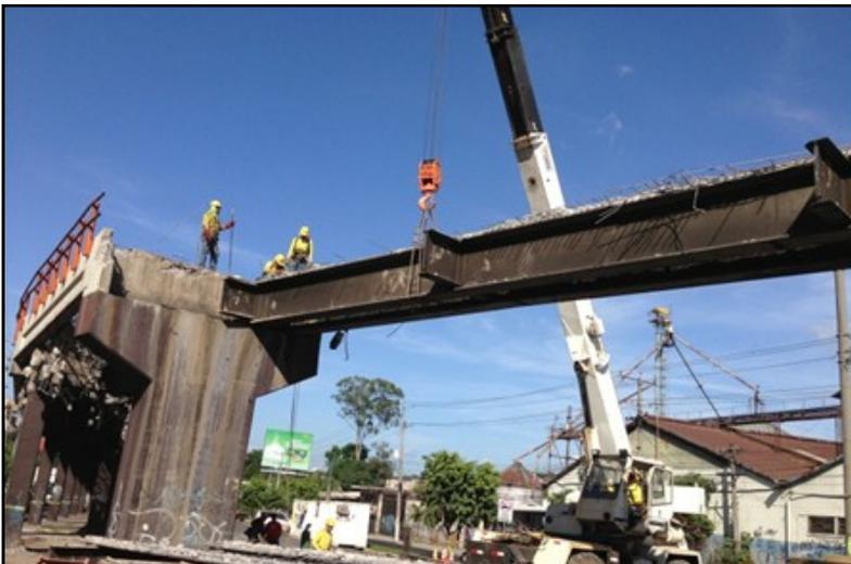
Parte de la estructura en demolición del Paso Superior José Arturo Castellanos que tenía una falla geométrica y que el nuevo que se construirá viabilizará mejor el tráfico.
