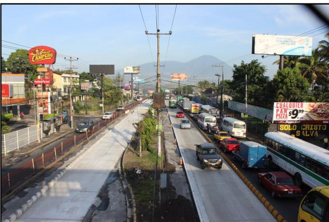
En la imagen se aprecia los dos carriles de concreto hidráulico que se están construyendo en el Bulevar del Ejército, correspondiente al Tramo I.
