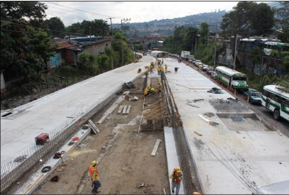
Vista de San Salvador a Soyapango donde se está finalizando la colocación del concreto hidráulico en las etapas 3 y 4 y se inicia con la construcción de la parada de bus.
