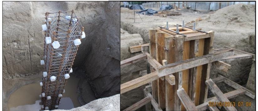
A la izquierda se muestra el armado de pedestal con zapata colada lista para ser encofrada, así estaba el 18 de octubre. A la derecha se muestra el pedestal encofrado listo para colar con concreto hidráulico, al 22 de octubre de 2013.
