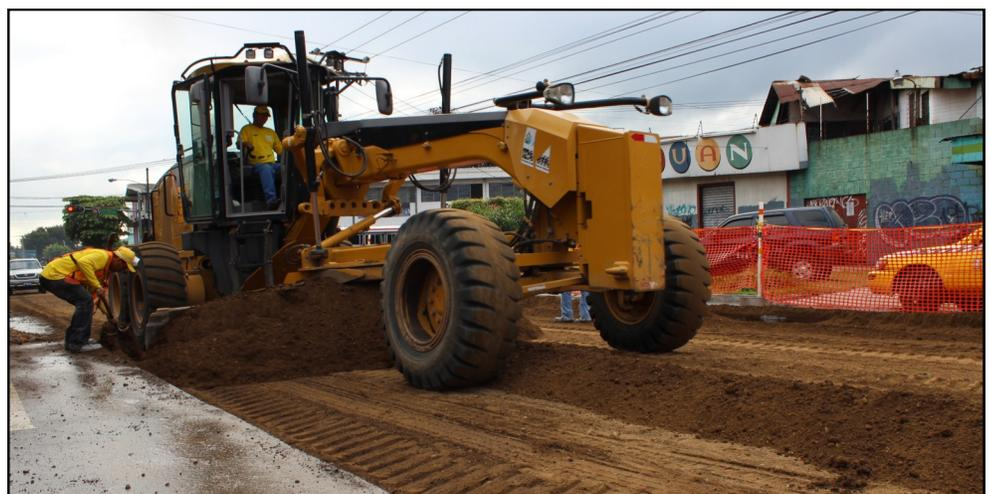
Momentos en que la maquinaria de ASTALDI coloca el suelo cemento para dejar preparado el camino para la colocación del concreto hidráulico en la Alameda Juan Pablo II.
