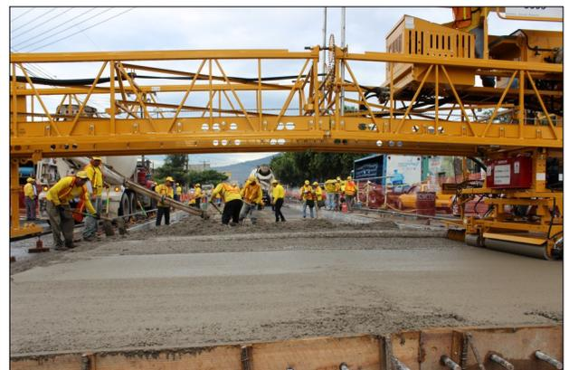
Maquinaria utilizada por Astaldi para aplicar el concreto hidráulico, que hasta el 11 de noviembre se han colocado 120 metros lineales
