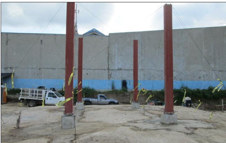
En la Terminal de Integración ya se comienzan a visualizar la instalación de columnas sobre los pedestales colados de concreto hidráulico.
