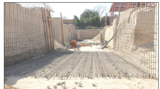
Armazón de hierro que le dará forma a los colados de concreto para el túnel peatonal dentro de la Terminal
