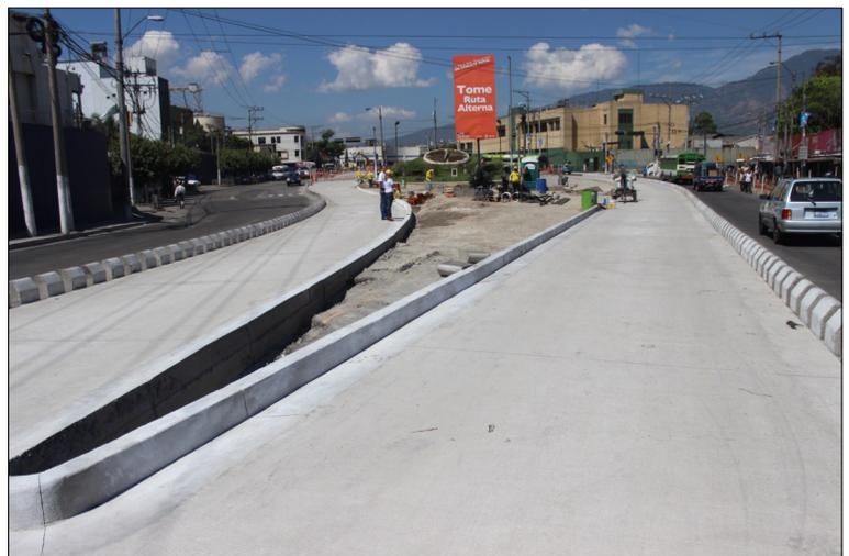
Vista desde Oriente del sector del Reloj de Flores, donde ya se finalizó en concreto, la instalación de los separadores y actualmente se construye el cordón cuneta; en esta Son se construirá una estación.
