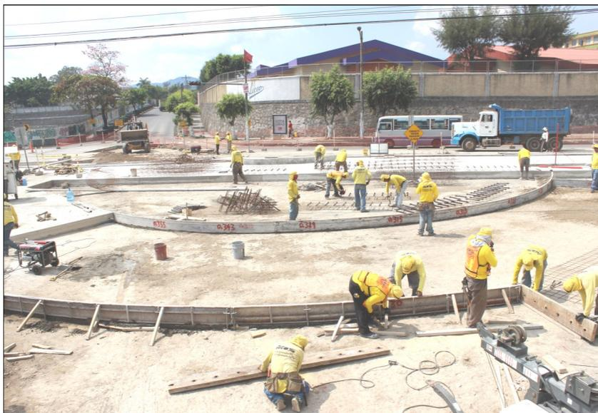
Obreros de ASTALDI trabajando en la construcción del retorno de los buses articulados en la intersección de la 33 Av. Norte y Alameda Juan Pablo II.
