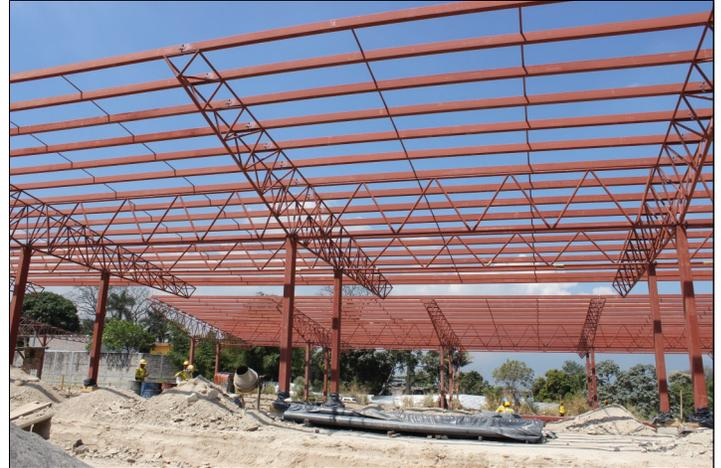
En la Terminal de Integración se están instalando una buena cantidad de vigas como parte de la estructura de los techos en los andenes .
