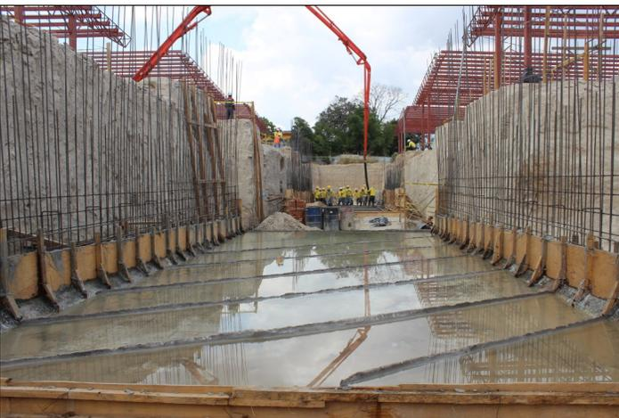
Estructura del túnel peatonal que se construye en la Terminal de Integración, la cual ya tiene 2 de 4 secciones coladas con concreto hidráulico y se arman 2 secciones más.
