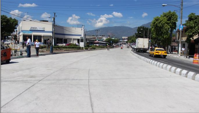
Sector de la Avenida Independencia donde ya se finalizó la pista de concreto hidráulico e instalación de la fibra óptica .
