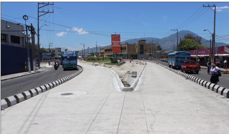
En el sector del Reloj de Flores ya se observa el carril segregado de concreto hidráulico con sus separadores y en este sector se han construido aceras en el costado norte de la calle.
