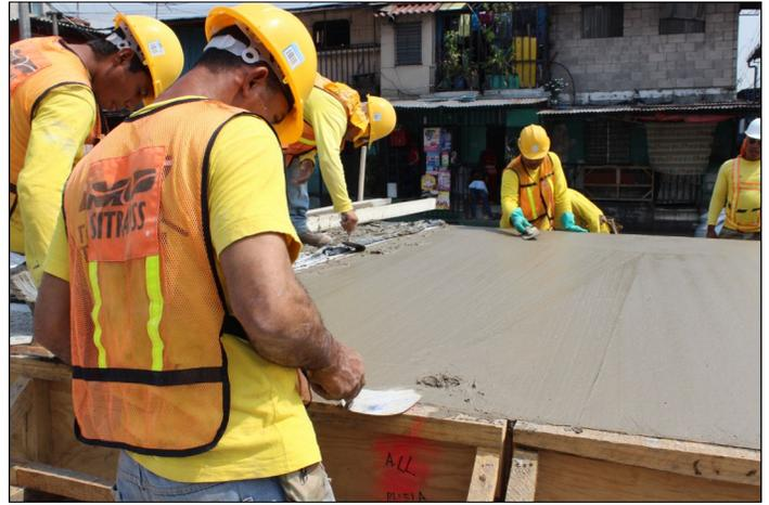
Obreros trabajando en el afinado de la plataforma de concreto en la Parada del Hospital Médico Quirúrgico del carril segregado del Tramo II del SITRAMSS.
