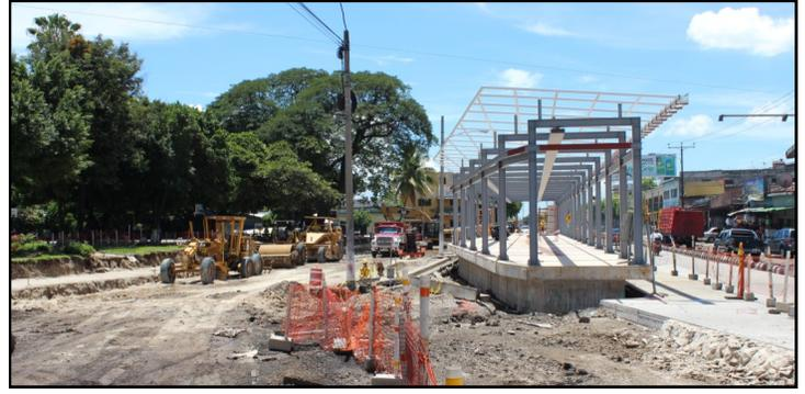
Estación de Autobuses del **Parque Centenario** ya tiene un avance constructivo del 79.50% correspondiente construcción de plataforma de concreto hidráulico, instalación de estructura metálica, rampas de acceso y señalética para personas con discapacidades. En las dos semanas anteriores se trabajó en la demolición de una parte del Parque para construir los carriles donde circulará el tráfico particular y los autobuses del SITRAMSS.
