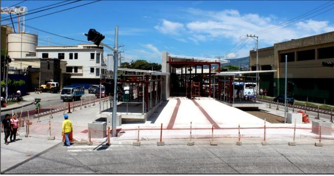
Estación de Autobuses del **Reloj de Flores** ya tiene un avance constructivo del 85.40% correspondiente a instalación de techos, pasamanos, rampas de acceso con su señalética para personas con discapacidades y pulido de estructura metálica.
