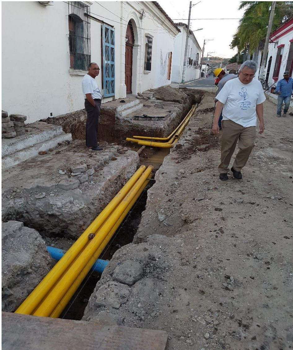
Instalación de tubería subterránea para cableado eléctrico y telecomunicaciones.
