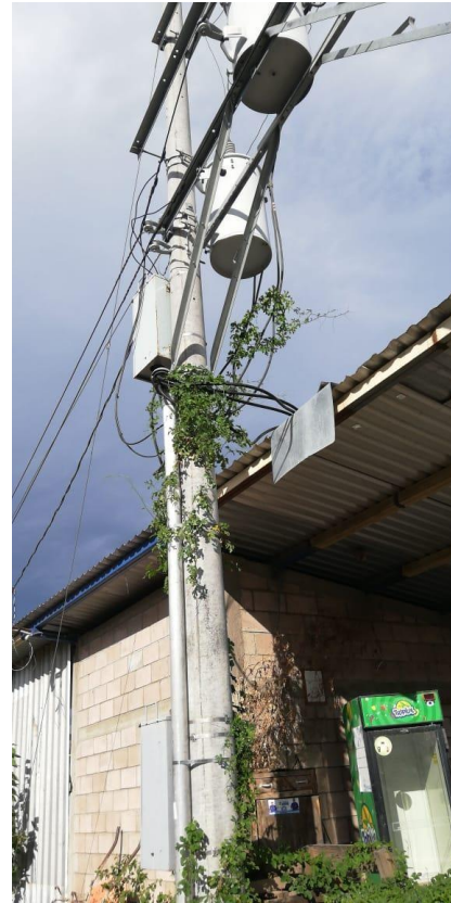
Mantenimiento de Sub-estación
