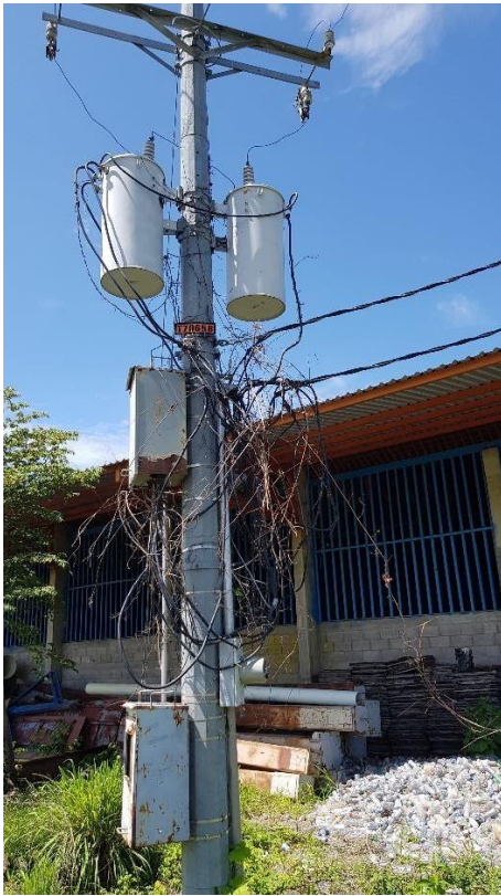
Mantenimiento de Sub-estación bombeo San Nicolás. Plantel Municipal.
