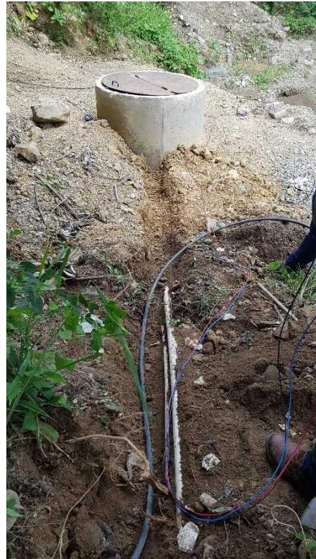
Instalación de luminarias, remodelación en concreto. Reparación de alimentador para bomba de agua de bodega en registro.
