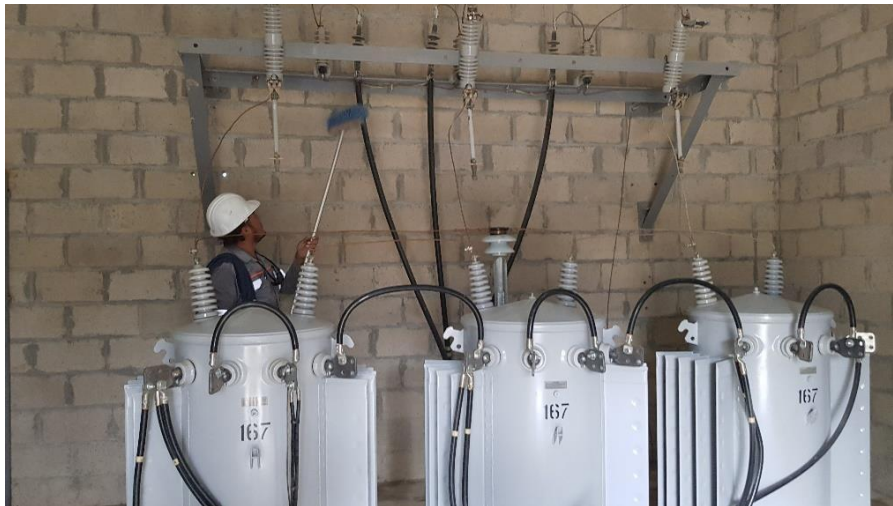
Mantenimiento a sub-estación planta trituradora y asfáltica
