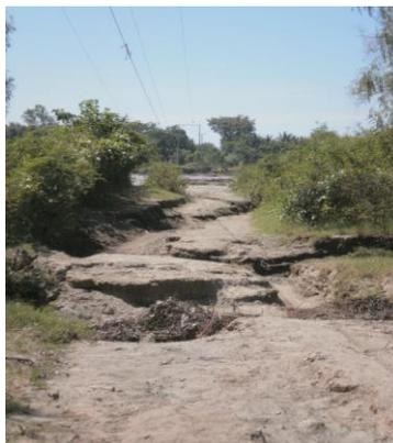
**Figura 1:** Estado actual de la vía de acceso secundaria tras el desbordamiento del río Jiboa.
