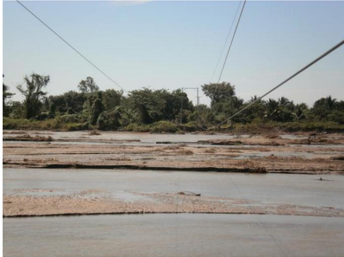
**Figura 2:** Tendido eléctrico que abastece a la comunidad, situado a menos de 2 metros de altura respecto al nivel de la vía secundaria de acceso.
