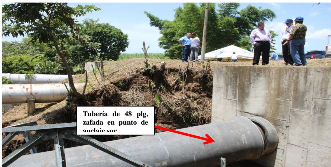
Debido al colapso de la tubería, las piezas desmontadas, fueron encontradas por personal de la ANDA en la quebrada.
