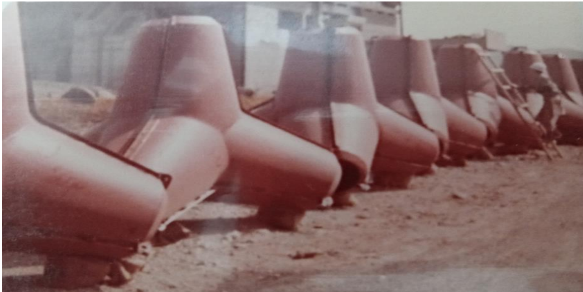
Imagen 26. Fotografías de colocación de tetrapodos de concreto que amortiguan las fuerzas de las olas en el Puerto de Acajutla, Álbumes fotográficos Archivo Central, CEPA.
