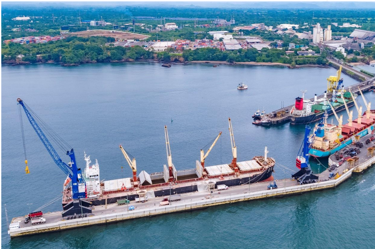
Imagen 38. vista de las grúas post Panamax, adquiridas recientemente en el Puerto de Acajutla
