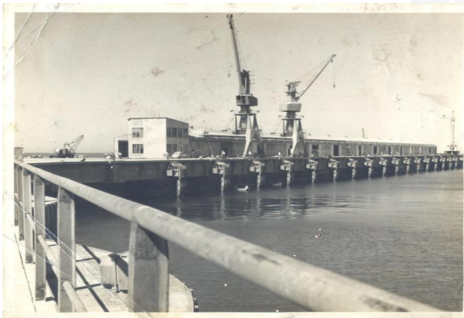
Imagen 24. Fotografía vistas de las grúas de semiportico, recién adquiridas para las operaciones de desembarque de mercancías del Puerto de Acajutla, FENADESAL, Archivo Periférico, Fondo FES-IRCA
