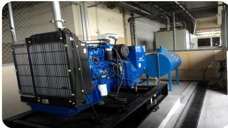
Suministro, instalación y puesta en operación de una planta generadora eléctrica trifásica de emergencia de 100 kva para el AIES
