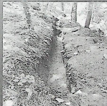
Mejoramiento y construcción de obras de captación de aguas lluvias tipo acequias y pozos de adsorción con el mejoramiento de 1,000 metros de acequias y la construcción de 50 pozos y 500 metros de acequias con una inversión de 1,500 aproximadamente.
