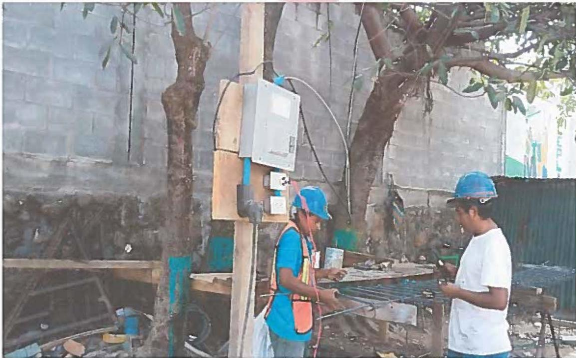
**ZONA CERCANA A LA CANCHA DONDE SE REUBICARÁ SUBESTACIÓN, POR DIFÍCIL MANIOBRA SE REQUIERE CAMBIO DE POSTE DE CONCRETO A POSTE METÁLICO.**
