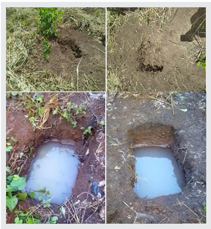
Para contribuir a la infiltración de aguas lluvias se construyeron 6,875 de fosas de Infiltración, con estas se lograrán captar e infiltrar al menos 69,300 m<sup>3</sup> por año, también se construyeron 50 metros lineales de diques para retención de agua, 50 reservorios.
