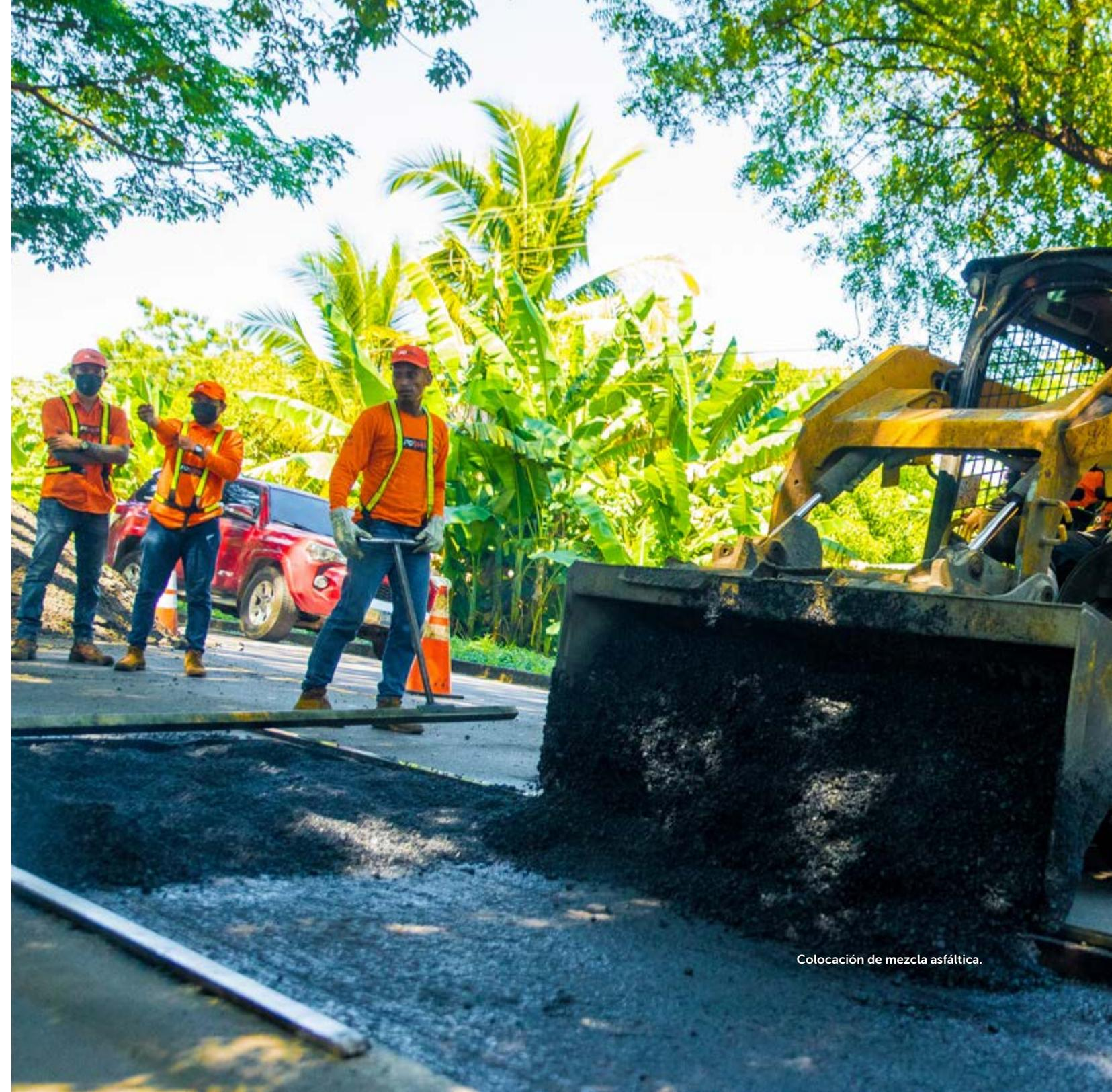
Colocación de mezcla asfáltica.
