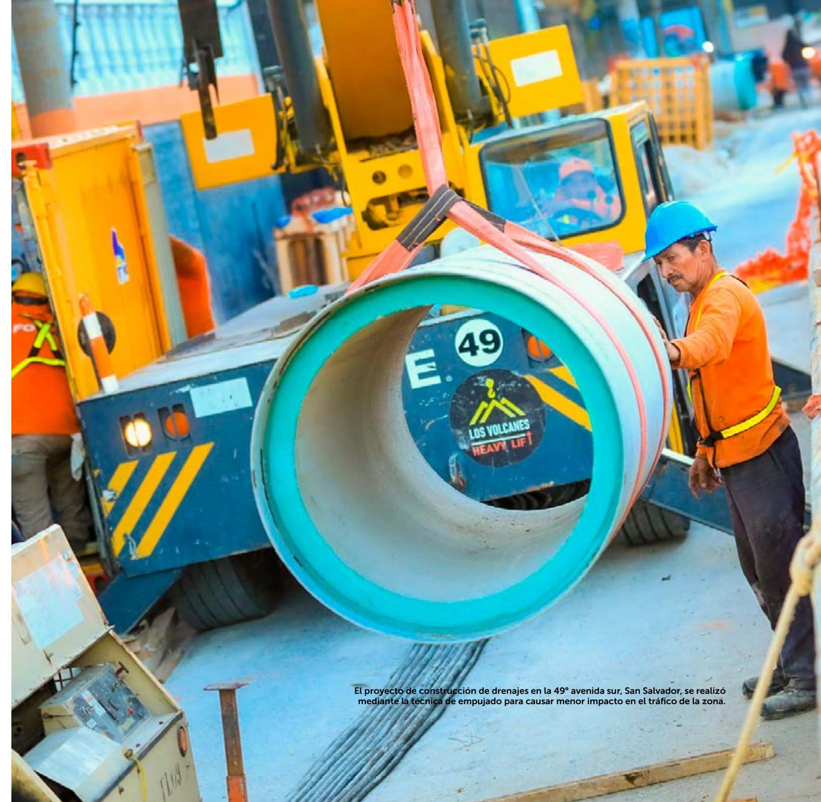
El proyecto de construcción de drenajes en la 49ª avenida sur, San Salvador, se realizó mediante la técnica de empujado para causar menor impacto en el tráfico de la zona.
