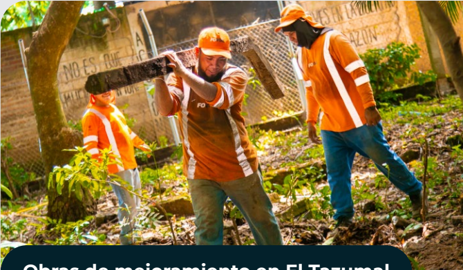
Obras de mejoramiento en El Tazumal
