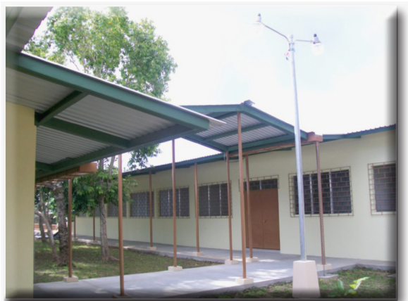
Construcción de la Unidad de Salud de Berlín, Usulután.
