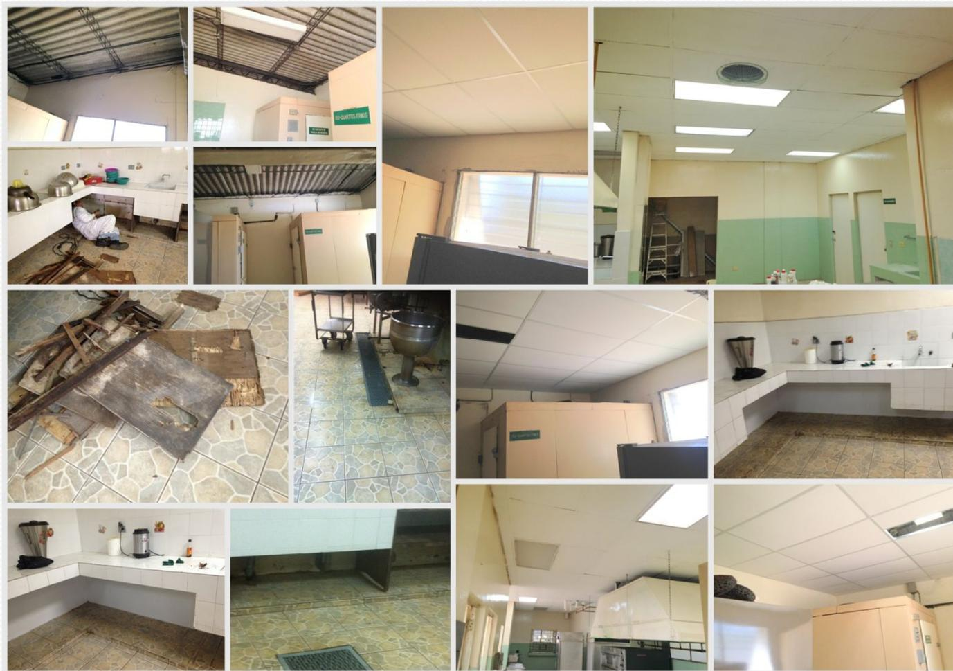
**Julio/Dic 2015 Enchapar paredes de lavamanos de alimentación y colocar cielo falso a sala de cuartos fríos y malla a tragantes de drenajes de agua**
