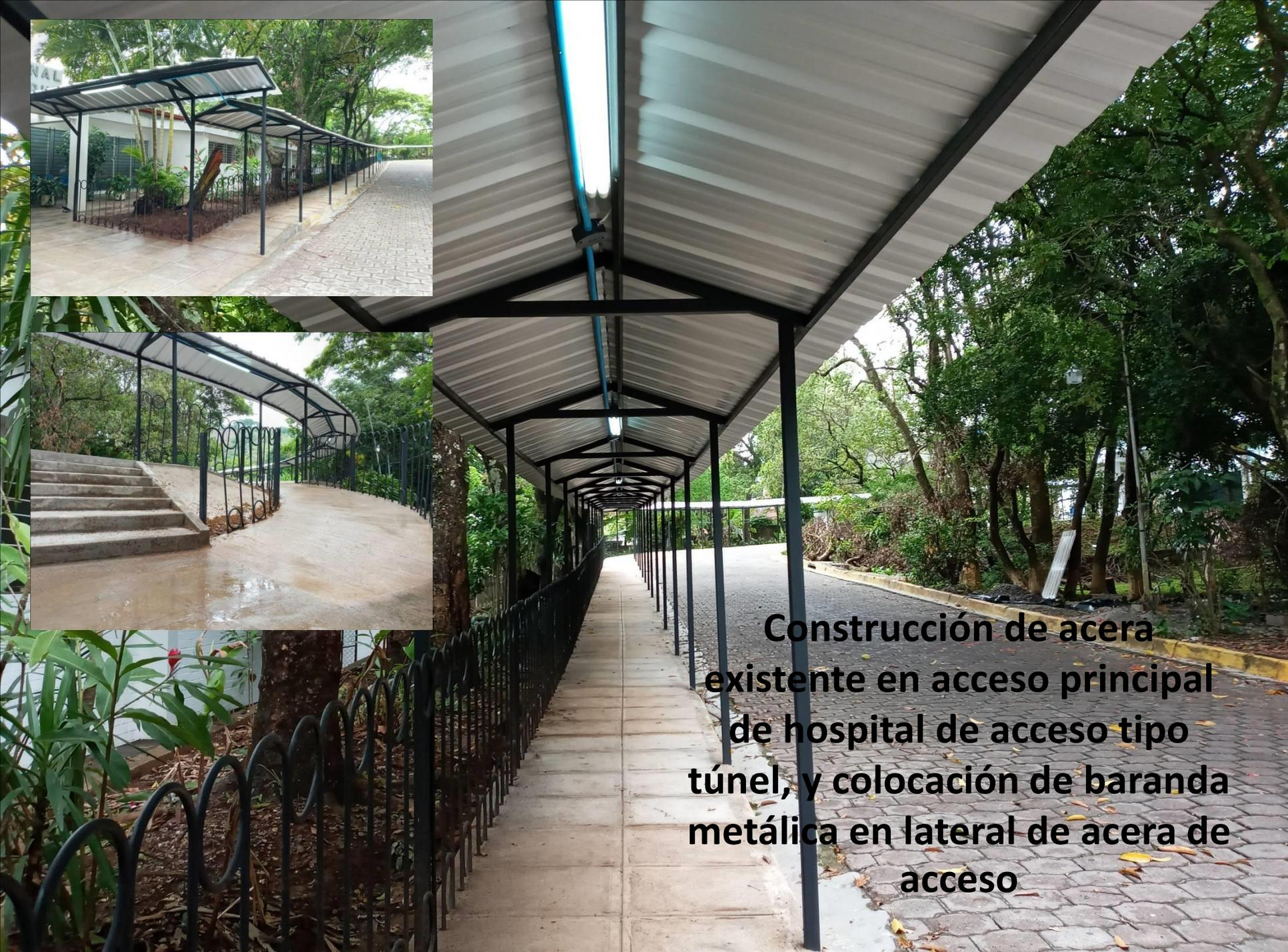
**Construcción de acera existente en acceso principal de hospital de acceso tipo túnel, y colocación de baranda metálica en lateral de acera de acceso**
