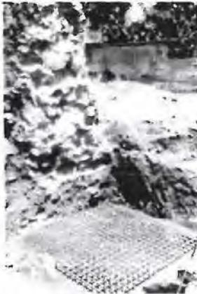
**013** colocacion de armadura en elemento de zapata z-5 en ejes 1- A,
