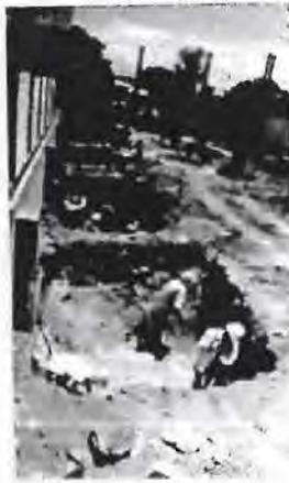
La fotografía muestra el eje C, cercano a ejes 19, 20, 21, donde se aprecia un suelo de tipo colapsable en la superficie, seguido de suelos densos y mezclas de bolones rocosos de gran tamaño, demostrando que esta zona del estadio se conformó como relleno en el pasado, por lo tanto, los suelos se encontraron de consistencia suelta en la superficie.
