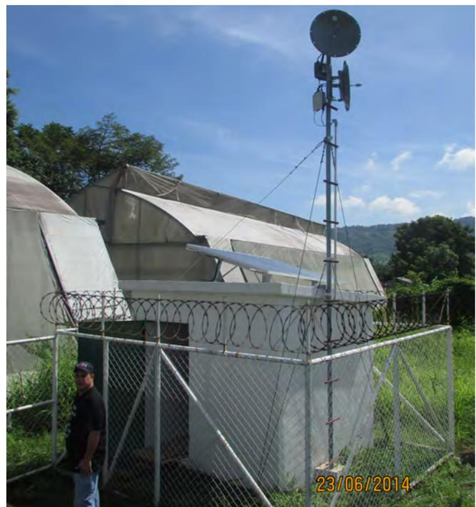
Fotografía 8. Estación sísmica con sismómetro de banda ancha instalada en San Andrés, Sitio del Niño, La Libertad.
