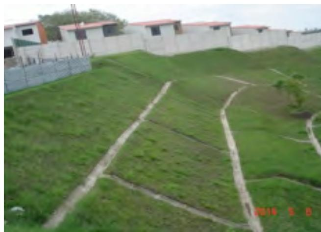
Fotografía 35. Construcción de Obras de Mitigación de Impactos Ambientales: Revestimiento de Taludes.
