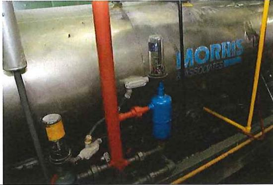
Foto 2: Personal de la empresa Avícola Salvadoreña explicando el proceso de operación del sistema de refrigeración industrial con amoníaco y el equipo que presentó la fuga de la citada sustancia.
