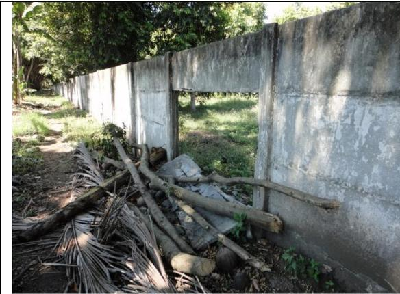
Foto 93. Losetas dañadas en el muro perimetral del costado norte de las instalaciones
