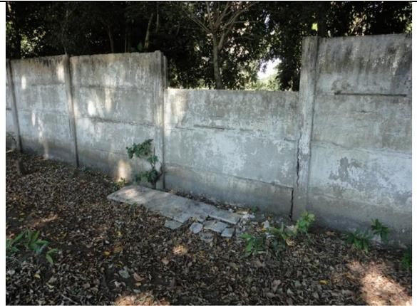
Foto 94. Loseta dañada en el muro perimetral del costado norte de las instalaciones. En este muro se encuentran varios sitios con deterioro similar en las losetas que ha sido causado por personas desconocidas.
