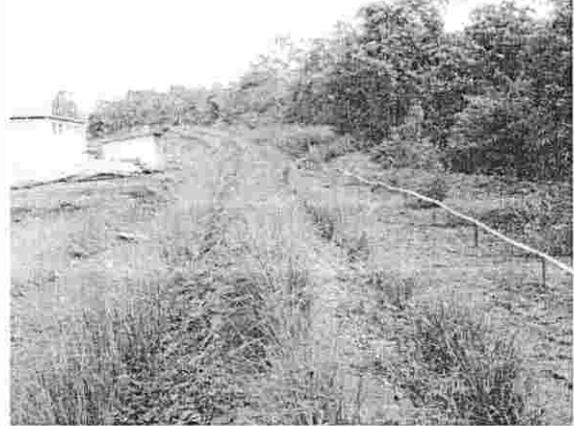
Foto#2. Conformación y protección de borda con Zacate vetiver.
