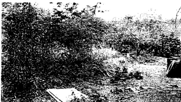
Foto 1. Observación de la borda sin mantenimiento con erosión y sin del zacate vetiver.
