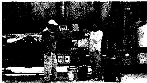
Foto 8. Falta de uso del equipo de protección personal (mascarilla, casco, lentes, guantes)
