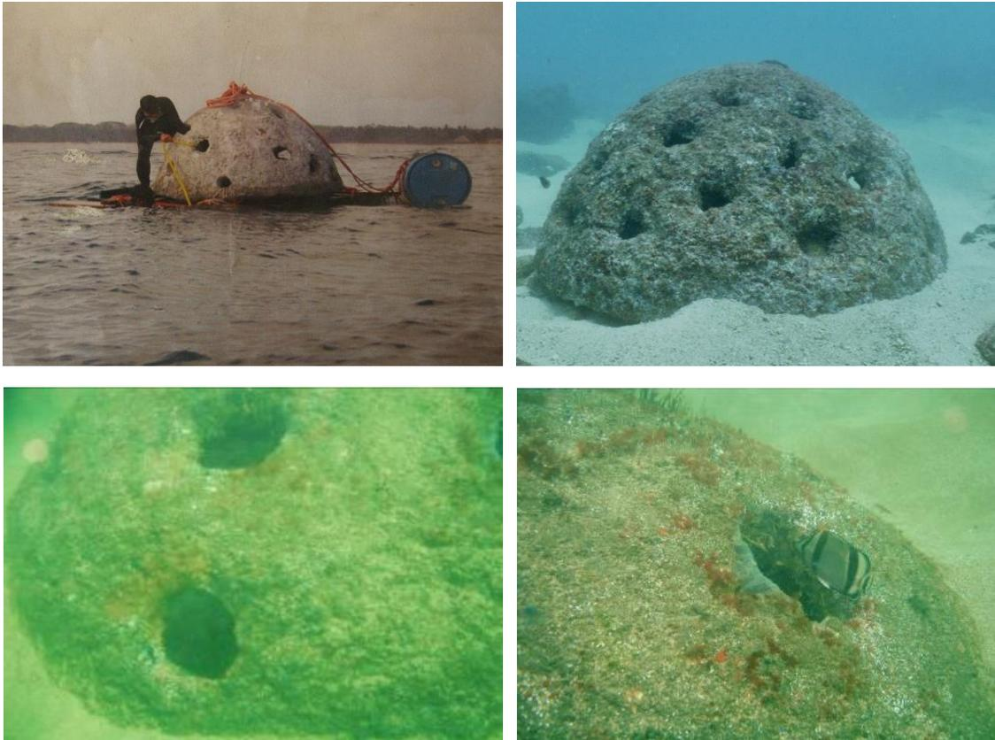
Figura 17. Fotografías históricas de Módulos arrecifales artificiales instalados frente a Punta Remedios, en el ANP y Sitio Ramsar Complejo Los Cóbanos, Sonsonate.
