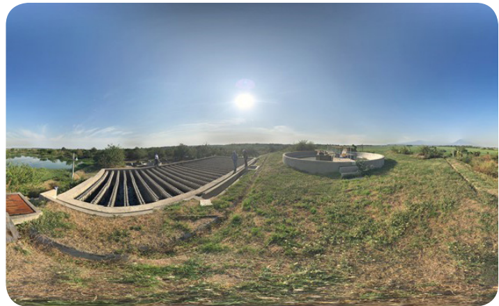
Vista de la planta de tratamiento de Puerto El Triunfo durante la visita técnica del Programa con representantes del BID, ANDA y MARN. 22 de marzo de 2017
