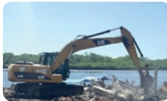
Inicio de la demolición de la plataforma de la Fuerza Naval, al final del muelle, con maquinaria del MOP y aportes de la alcaldía. 17 de noviembre de 2016.
