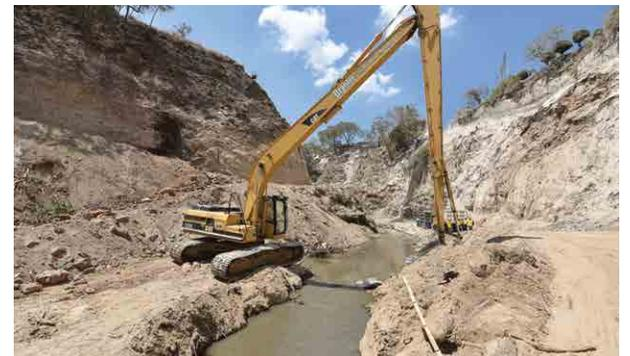
El Ministerio de Obras Públicas, a través del Viceministerio de Vivienda y Desarrollo Urbano, ejecuta la construcción del primer proyecto de Amortiguamiento del macro drenaje pluvial, a través de la construcción de Lagunas de laminación en la cuenca del Arenal de Montserrat, con la finalidad de reducir el riesgo por inundaciones en el Sector Sur de San Salvador.
