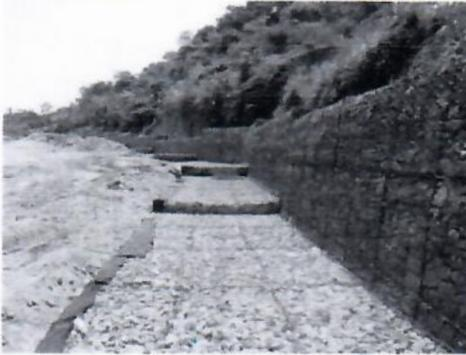
En la ingeniería civil, un muro de gaviones es un muro de contención hecho de contenedores rectangulares (cestas), fabricados de alambre galvanizado en gran medida, estos son llenos de piedras apiladas, unas sobre otras.
