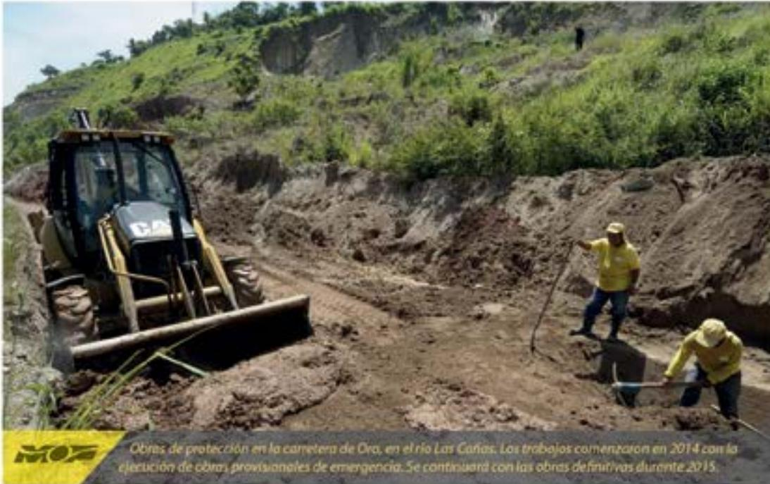
y amenazaba seriamente con cortar la principal vía de comunicación del país y de Centroamérica. En la modernización del sistema de drenaje se ha excavado hasta 17 metros para demoler la tubería dañada y construir una nueva caja de captación, todo con una inversión superior a los \$ 900 mil.
