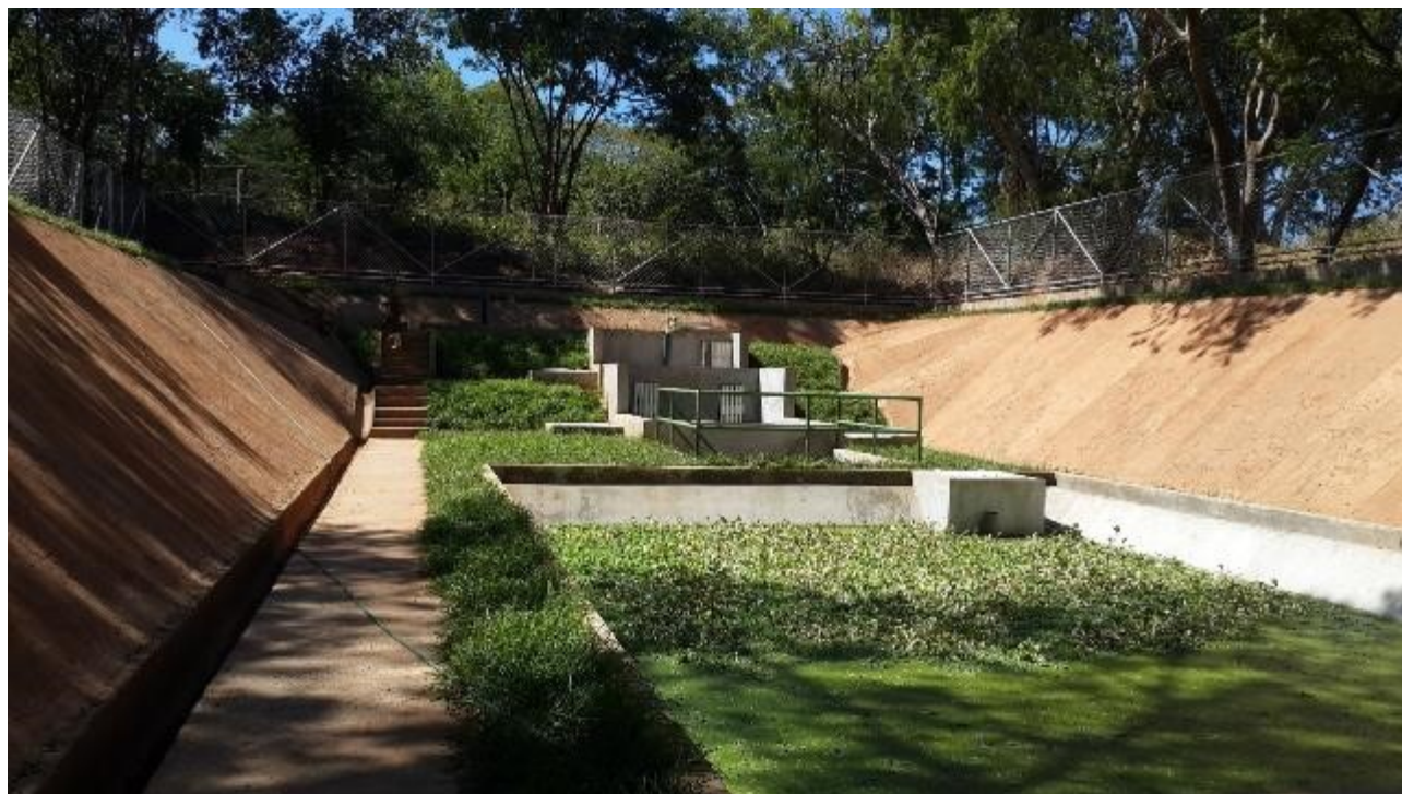
Reparación planta de tratamiento de aguas residuales del DM-3.
