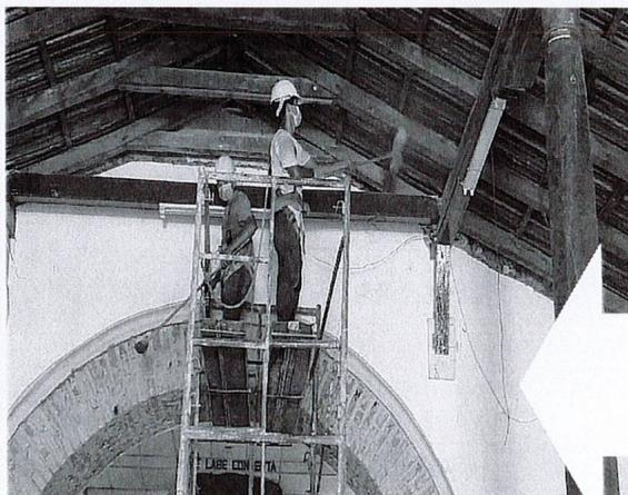
**Desmontaje de cielo falso.** Esta actividad se desarrolla primeramente desmontando los elementos de soporte de manera inversa al proceso constructivo. Es decir, con la desinstalación de listones de madera. Para luego dar paso al desmontaje de piezas de madera de cielo falso. Las piezas desmontadas se están acopiando para su posterior evaluación de daños y saber si serán reutilizadas o descartadas.
