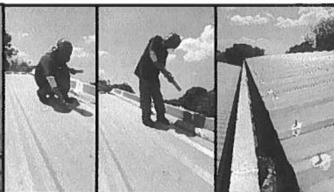
Sellado de Filtraciones de Agua en Techos
