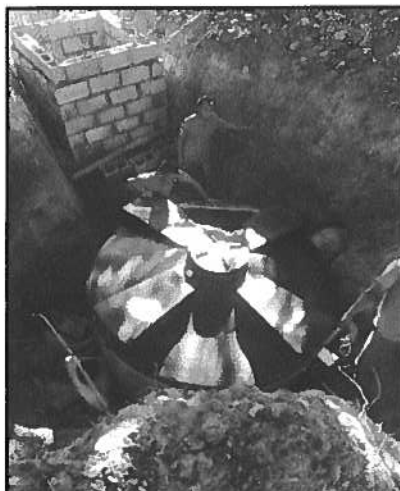
Construcción del Sistema de Aguas Residuales
