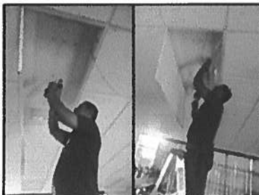
Cambio de luminarias LED
