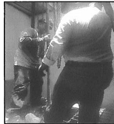
Mantenimiento de Pozo y Cisterna
