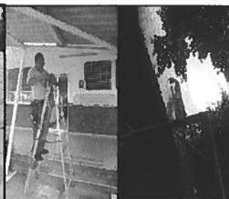
Instalación de Alarma Anti-Robo
